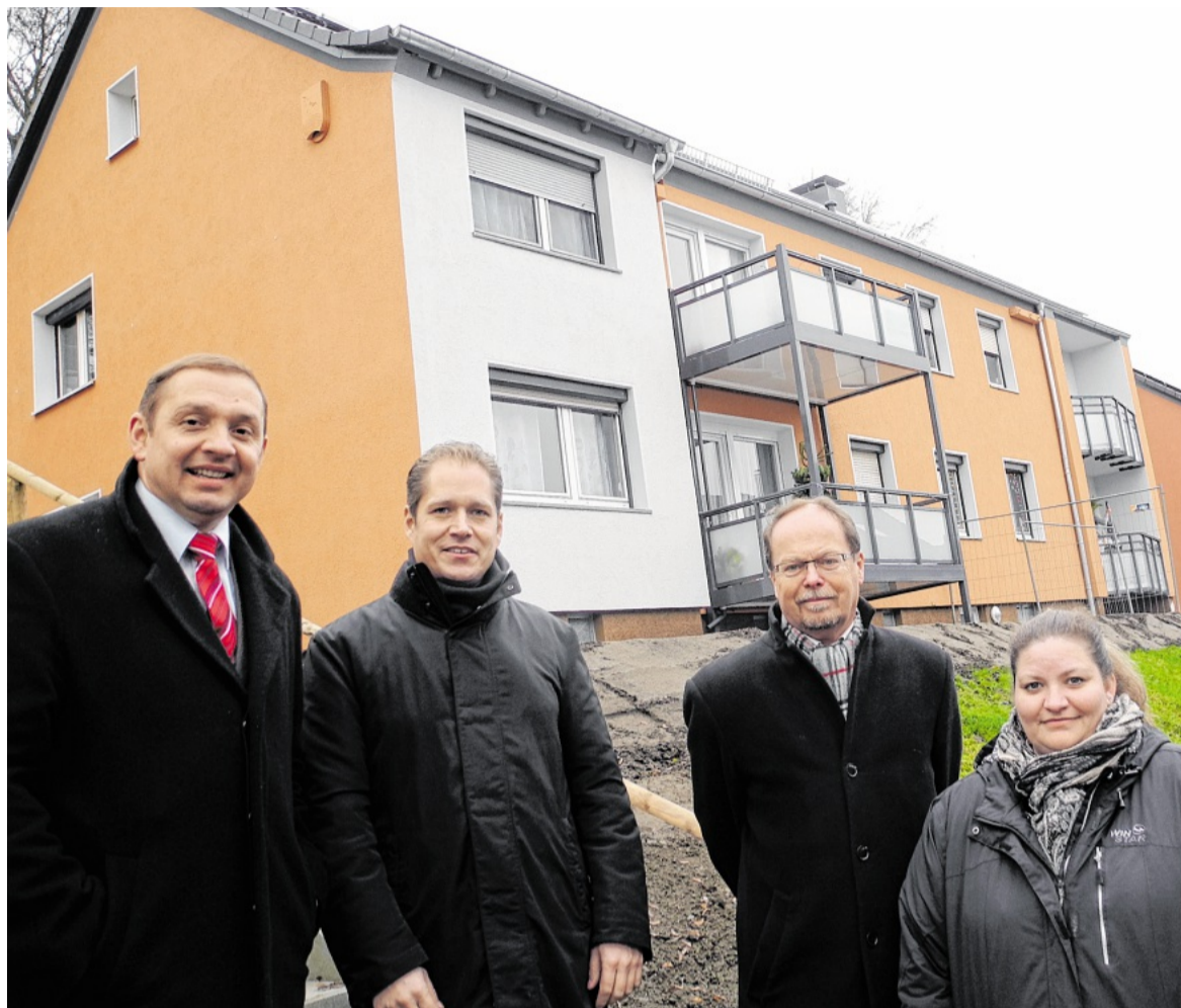
Kurz vor der Fertigstellung an der Schillerstraße: EN-Wohnen-Geschäftsführer Alexander Dyck (links), der Aufsichtsratsvorsitzende Oliver Flühöh (2.v.li.) und Prokuristin Meike Riedesel-Nüßgen gaben ein Lob an die Stadt Wetter – vertreten durch Manfred Sell (Mitte). „Die Zusammenarbeit ist vorzüglich.“
