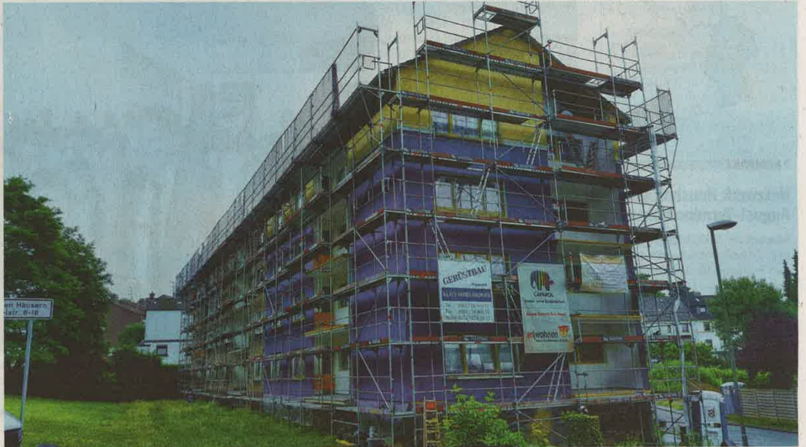
EN-Wohnen investiert wie hier in der Hegelstraße in Schwelm in energieeffizientere Gebäude. „Das hilft den Mietern, weil die Betriebskosten sinken. Das ist gleichzeitig unser Beitrag zum Umweltschutz“, sagt Geschäftsführer Manfred Kühn.
