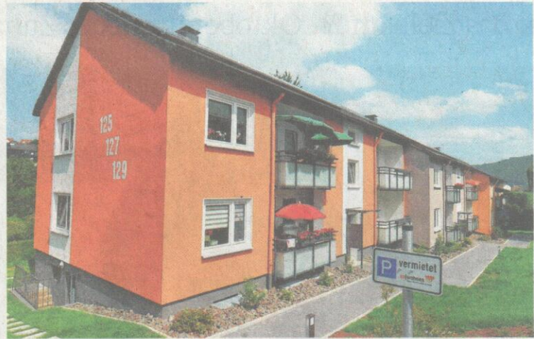
Vorzeigebauwerke für die en|wohnen GmbH: die sanierten Häuser in der Siltscheder Straße in Gevelsberg.
