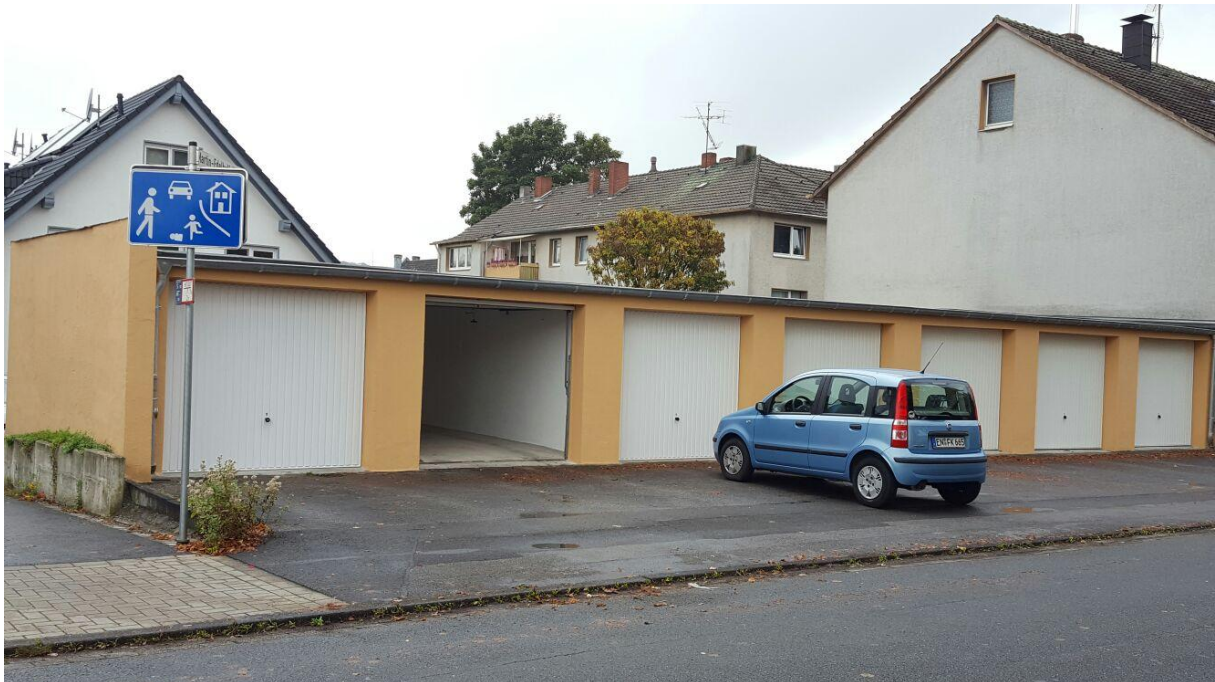
Garagensanierung Steinstraße 4 in Wetter
